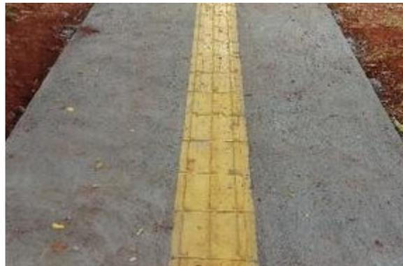
O piso tátil de alerta e direcional conforme apresentado no modelo da rampa utilizada em projeto. A cor será amarela e concreto natural, seguindo as descrições da norma.
