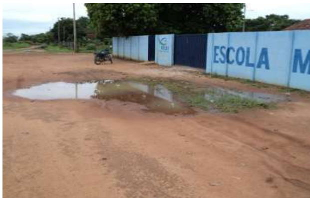
Alagamentos e ausência de drenagem pluvial
