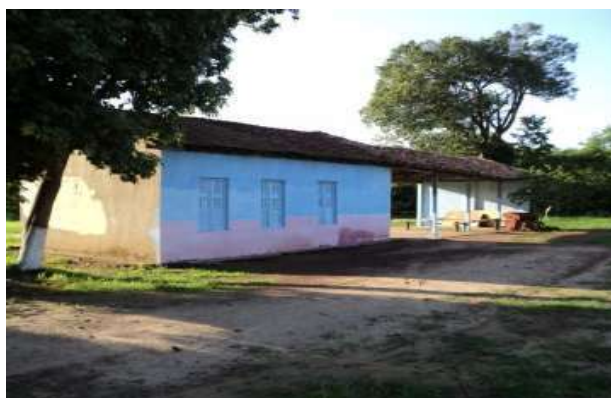
Ausência de coleta de lixo e sistema de drenagem pluvial
